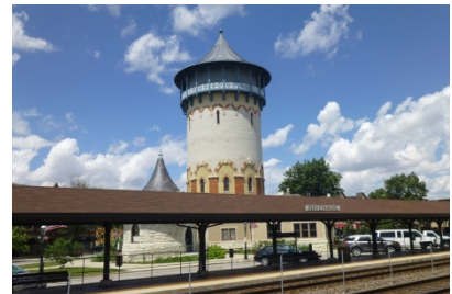
Riverside 駅ホームとランドマークの給水塔
